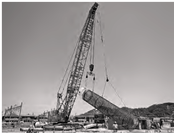
敦賀駅東側の整備状況
